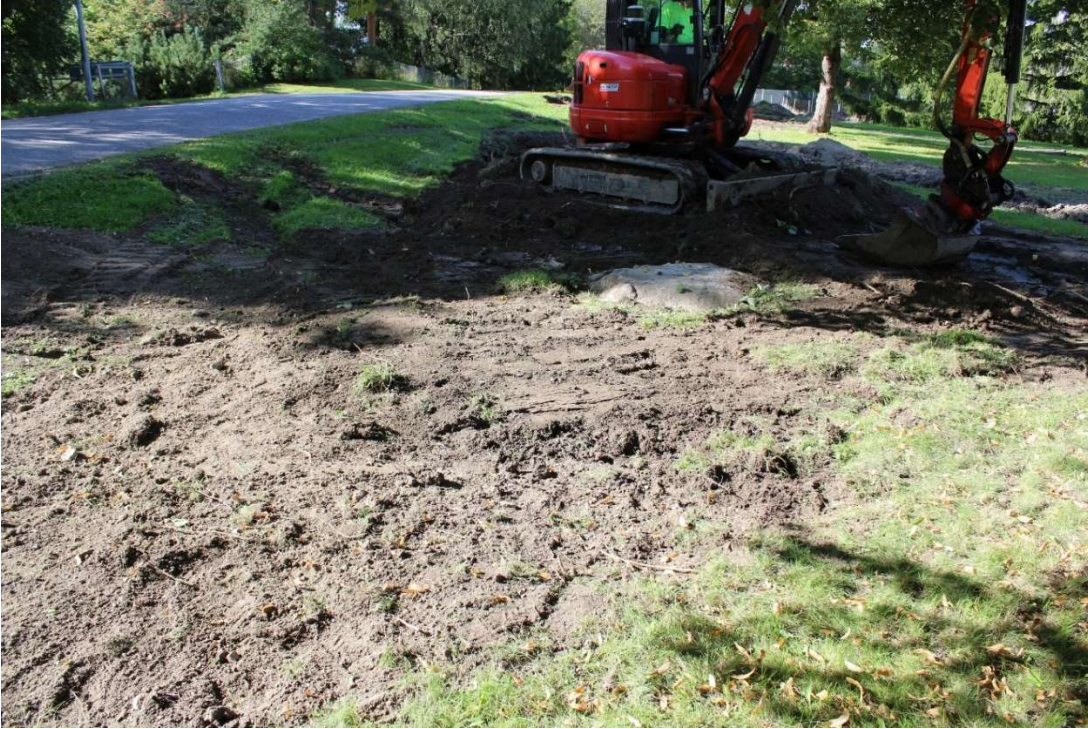
akdg6459:48. Työkuva. Ojan 3 laajennusta täytetään. Etelästä.
