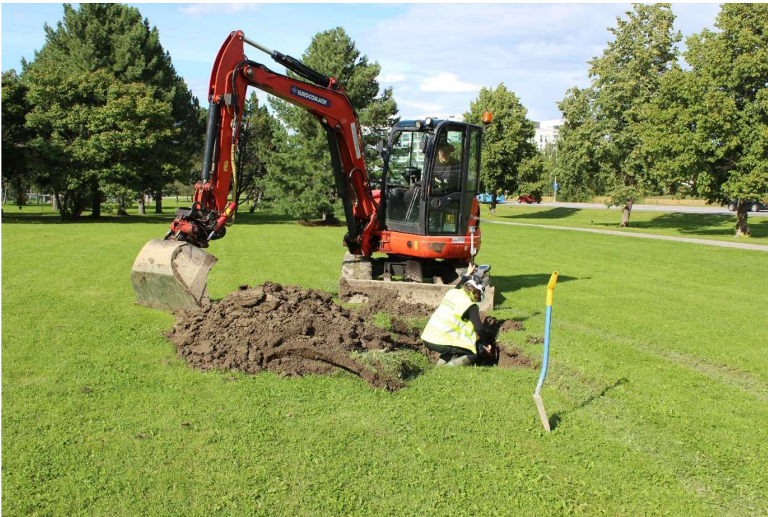
akdg6459:30 Työkuvaa. Oja 9 kaivetaan kaivinkoneella.
